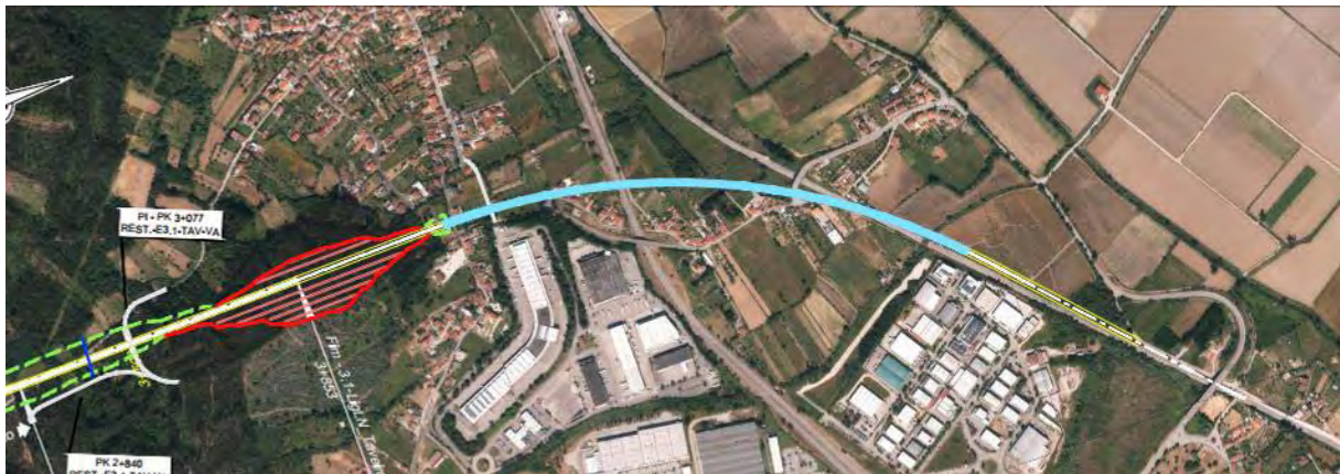
Figura 4.125 – Troço de ligação à Linha do Norte, em Taveiro
