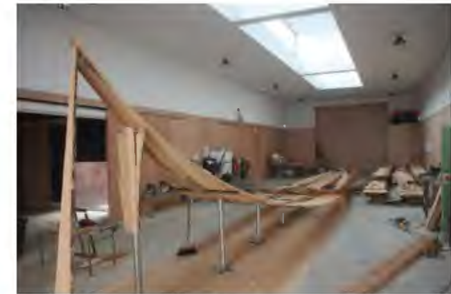
Início da construção de um barco moliceiro pelo Mestre José Rito no Estaleiro-Museu do Monte Branco © Município da Murtosa, 2021
